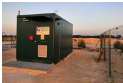
+ de 150 postes d'injection biométhane fabriqués et installés ou en fabrication - France
