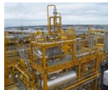
Unité de déshydratation et de régénération du gaz glycol en OFFSHORE - Azerbaïdjan
