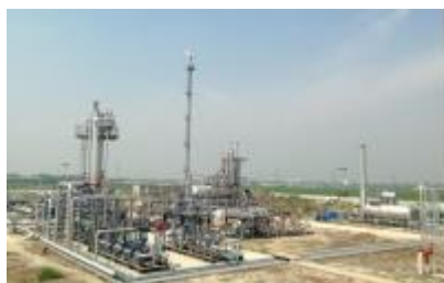
Unité de collecte et de traitement du gaz - Bangladesh
