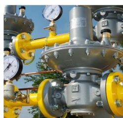
distribution industrielle et publique
