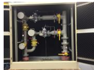
+ de 200 Fabrications de poste de distribution Gaz Naturel par an - France
