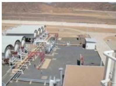
Station de stockage et de distribution de GPL - Algérie
