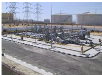
Unité complète de traitement du gaz : réchauffeurs/réduction de pression/filtres/déshydratation...etc -Turkménistan
