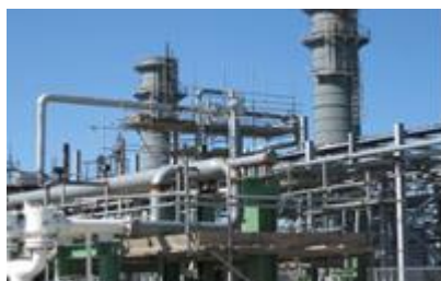
Unité de conditionnement de gaz combustible - Kazakhstan
