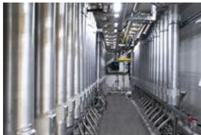
2 épurations biogaz en parallèle : capacité nominale 1800nm 3 /h de biogaz, capacité maximale 2700nm 3 /h de biogaz – Italie
