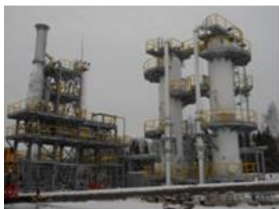
Unité de déshydratation et de régénération du gaz glycol - Lettonie
