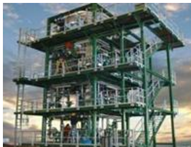
Unité de traitement du point de rosée du gaz - Nigeria
